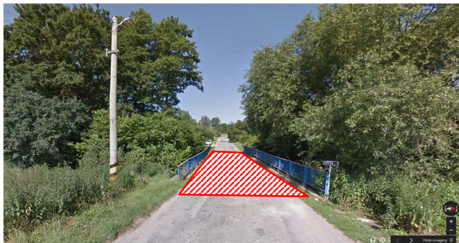
Most 37720 - 1, zesílení obrusné vrstvy - tl. max 40 mm
